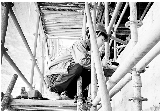
连日高温晴热天气,给混凝土出厂质量把控及施工现场混凝土结构稳定性带来严峻考验。为核查出厂混凝土实体质量,精准掌握现场结构混凝土实际强度,从源头把控品质,近日,建材控股漳州公司组织专业技术人员深入在建项目施工现场,开展回弹摸底检测工作。(王文静 摄)
