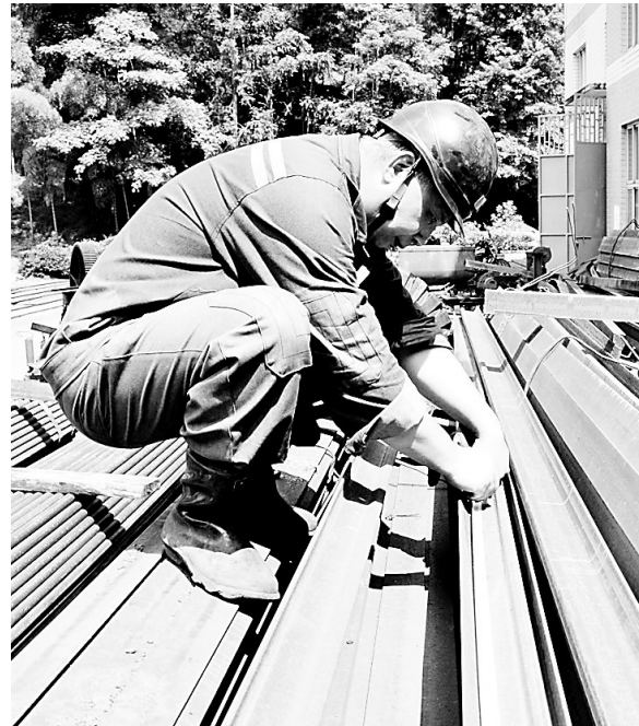
近期气温持续攀升,热浪席卷矿区,永安煤业公司池坪坑煤矿的广大职工不惧高温“烤”验,坚守在各自的岗位上。图为6月1日,该矿机队职工冒着酷暑对轨道进行标注。(陈思洲 摄)
